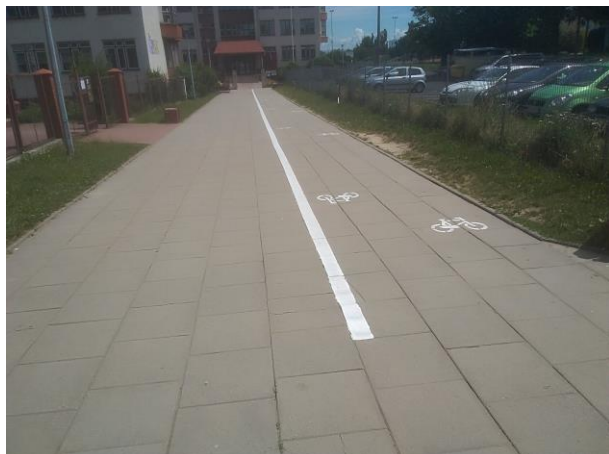
Zdjęcie 11. Ciąg pieszo - rowerowy prowadzący do głównego wejścia do szkoły
