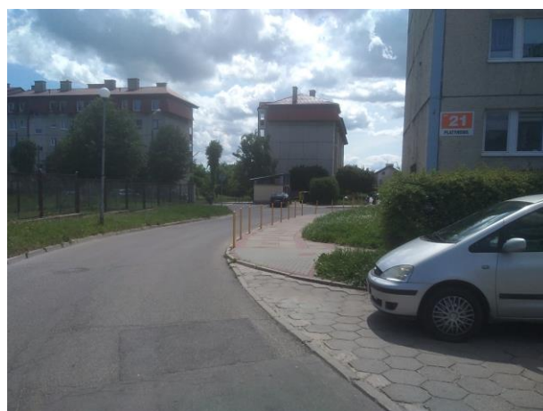
Zdjęcie 22. ul. Krzemowa w kierunku ul. Platynowej - brak ciągłości chodnika
