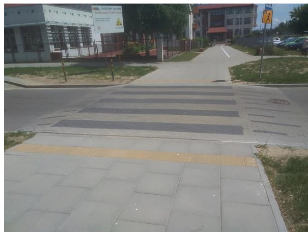
Zdjęcie 4. ul. E. Hoene - wyniesione przejście dla pieszych
